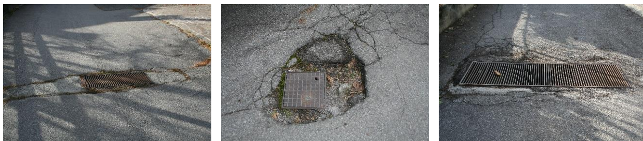
Fig. 13. Pozzetti per evacuazione acque piovane e per sottoservizi lungo le vie della frazione di Nembra di Edolo.
